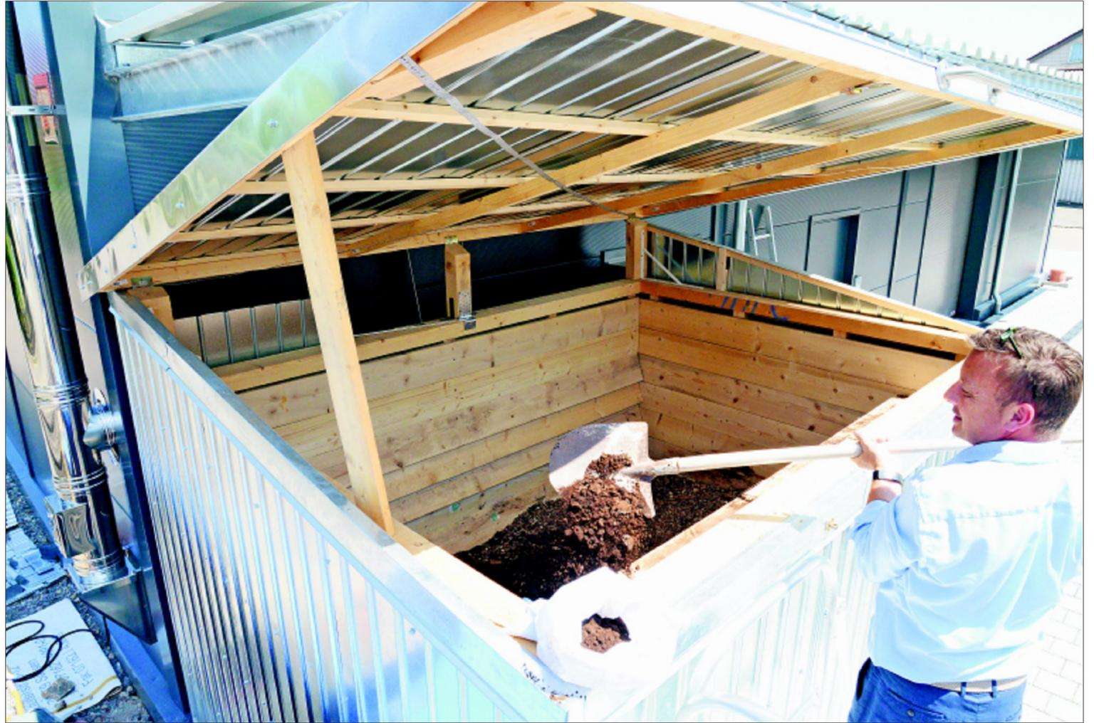
Oliver Lachenmann kippt eine Schippe Kaffeesatz in sein großes Vorratssilo hinterm Haus. Im Gebäuderücken grenzt unmittelbar der Heizraum an: Per Förderschnecke wird der Brennstoff direkt in den Brennraum des Ofens transportiert
